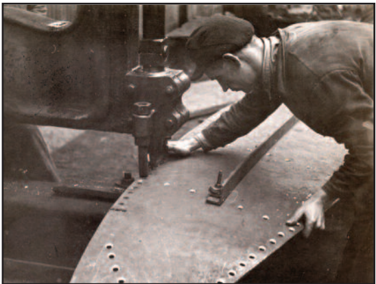
Hoewel men al snel experimenteerde met laswerk, werden de schepen voornamelijk geklonken. Bij de foto het ponswerk voor de klinkgaten. In de vitrine liggen een aantal ponsdoppen.
