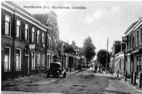
De Hoofdstraat West jaren twintig, met links logement De Dolfijn.
