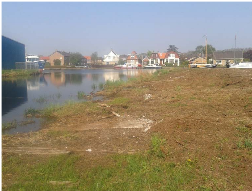
Afbeelding 12. De westkant van het plangebied richting het noordwesten. De met puin verharde grond ligt bezaaid met sloopmateriaal, vooral metalen voorwerpen en hout.
