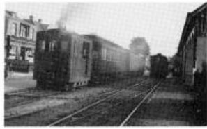
Tram naar Oosterwolde (met locomotief 9) te Gorredijk, in aansluiting op de tram Heerenveen - Drachten (die op de achtergrond staat); 1941. Foto G. J. de Swart (155.982 C)
