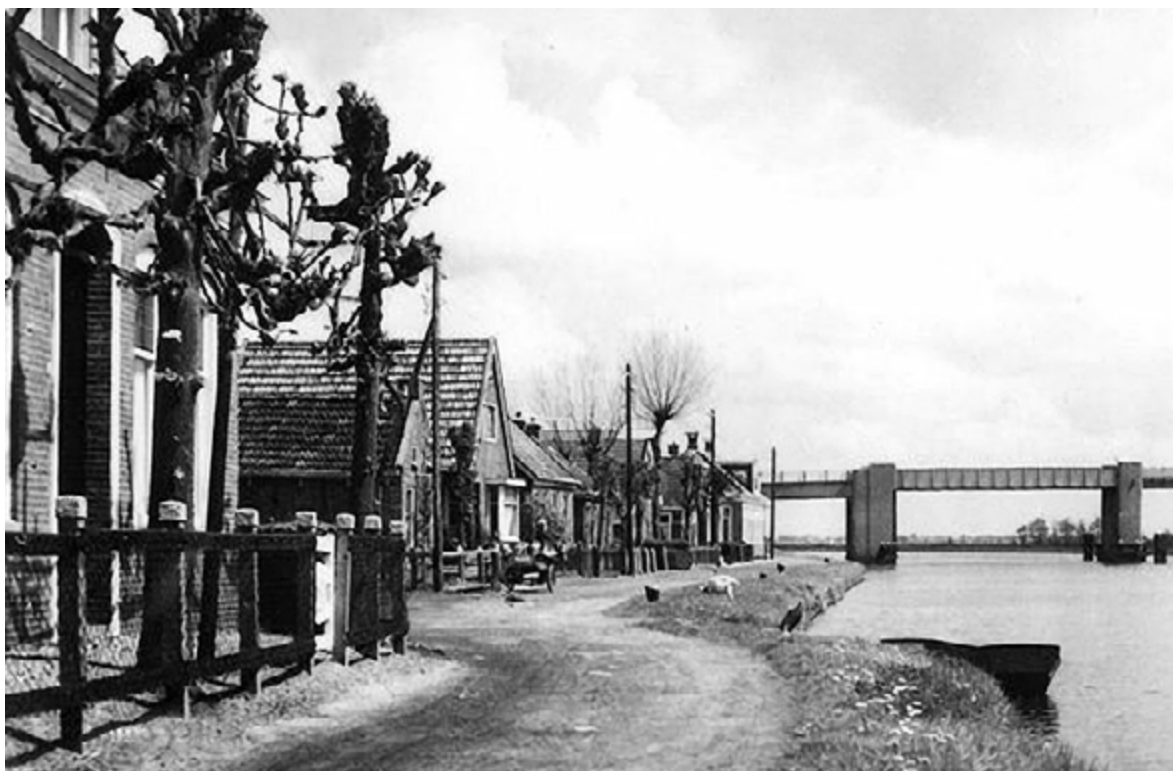
De grootschalige vormgeving van de bruggen vormen een contrast met de dorpen. Brug bij Blauferlaet, 1960.
