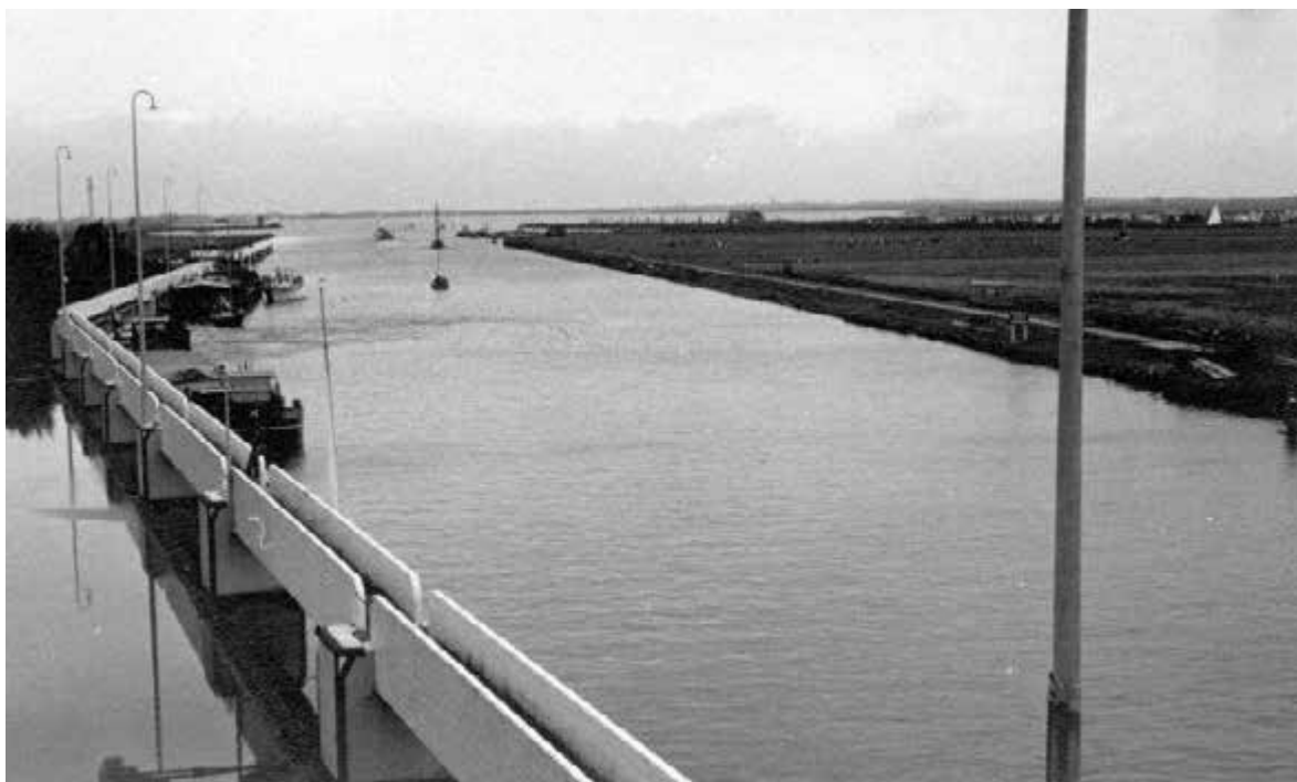
Het sluisencomplex kreeg wit geschilderde meerstoelen met loopbruggen.
