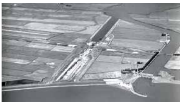
De aanleg van een nieuwe sluis in Lemmer, 1949
