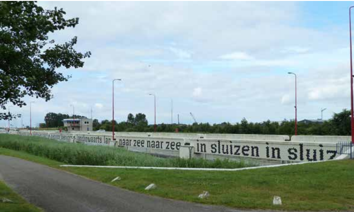
Foto's van sluis Terherne
